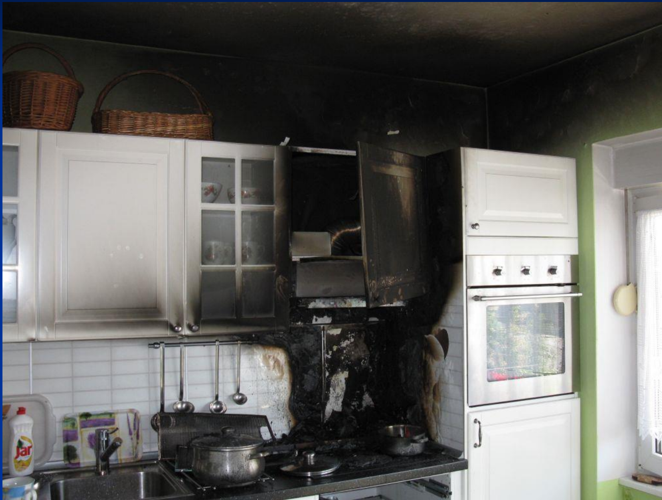
8. typický ohniskový kužel při požáru kuchyňské linky v rodinném domě
