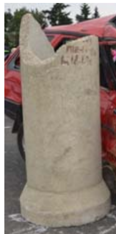
Betonová nebo železná roura min. průměr 60 cm, délka cca. 150 – 200 cm
