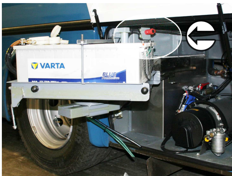
Obrázek 80: Mechanický odpojovač na stěně schránky akumulátorů, která je předposlední vlevo. Vlevo je svislá osa, kolem které se saně akumulátoru vytáčí
