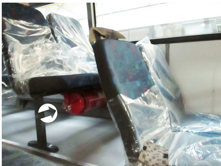
Obrázek 73: Ruční hasící přístroj upevněný pod sedákem cestujících
