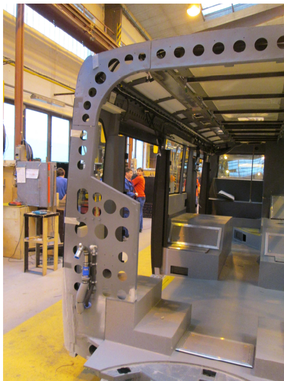
Obrázek 44: Detail čela zadního dílu kloubového autobusu ve výrobě. Na snímku jsou patrné hadice, které propojují přední a zadní část vozu (chladicí kapalina pro topení, tlakový olej pro pomocné funkce), elektrická vedení a vedení tlakového vzduchu
