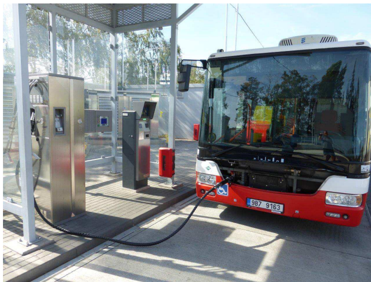
Obrázek 19: Plnění autobusu vyvedené do prostoru předního čela
