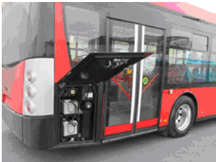
Obrázek 43: Umístění palubních akumulátorů 24 V - jediná schránka vpravo. Mechanický odpojovač palubních akumulátorů je přístupný zadním víkem
