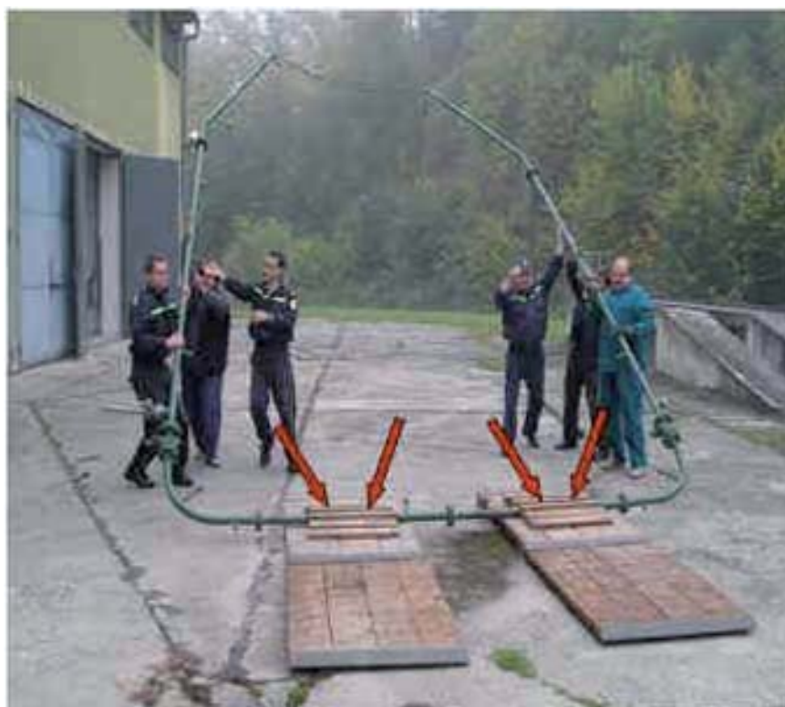
Obr. 74 Stavba mycího rámu
