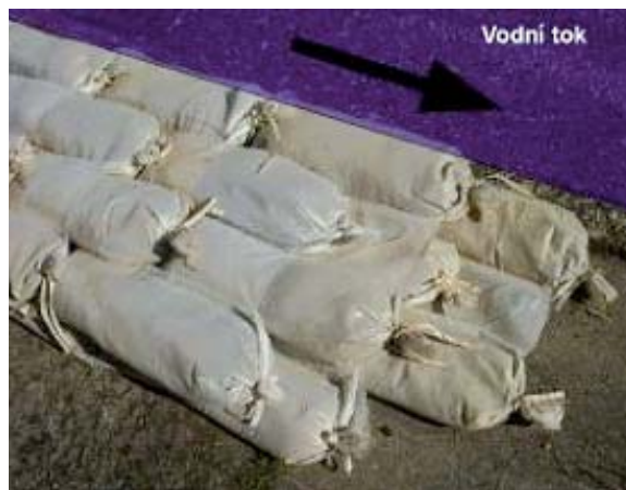
Obr. 17 Způsob kladení dvoukomorových pytlů
