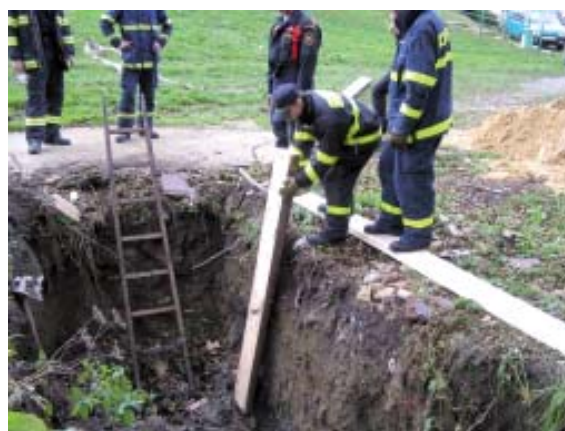
Obr. 84, 85 Ilustrační foto z nácviku zajištění výkopu
