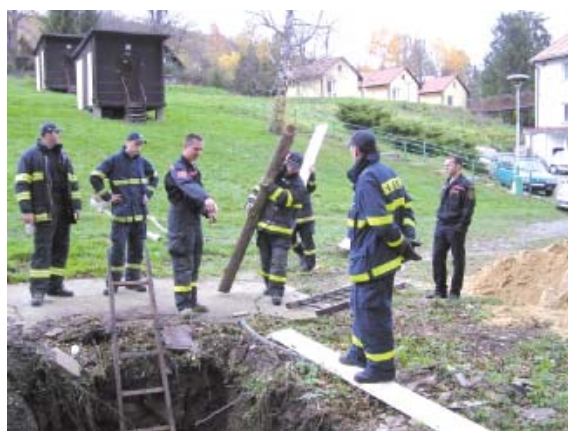
Obr. 84, 85 Ilustrační foto z nácviku zajištění výkopu
