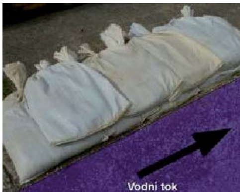
Obr. 6 Způsob kladení jednokomorových pytlů
