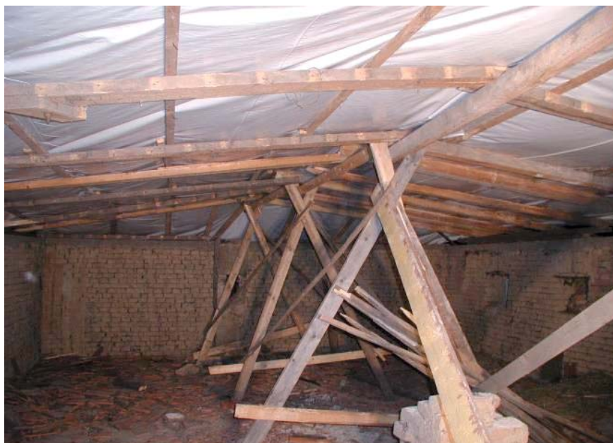
Obr. 86 Ilustrační foto provizorního zastřešení, včetně provizorní konstrukce
