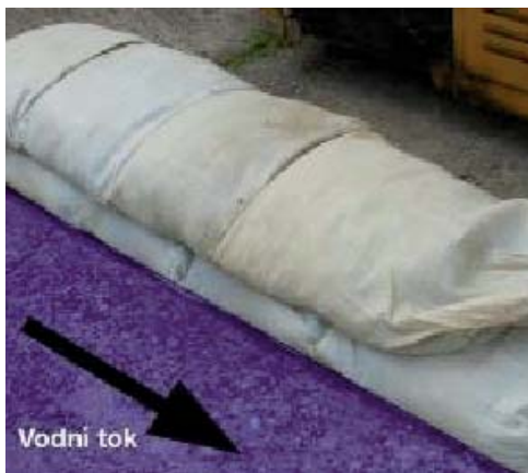
Obr. 7, 8 Způsob kladení jednokomorových pytlů (podélně, schématicky)
