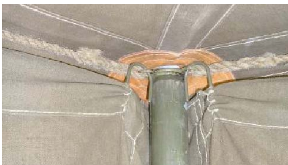
Obr. 35 Detail zavěšení bočních stěn u boční podpěry
