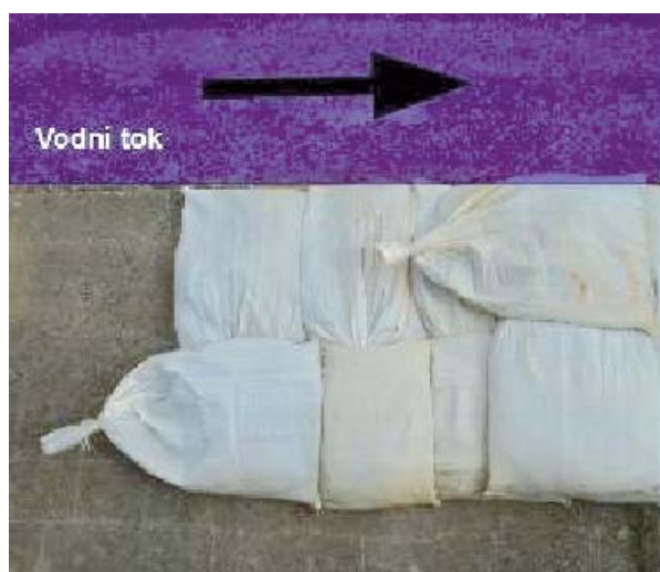
Obr. 10, 11 Kombinované víceřadé kladení jednokomorových pytlů
